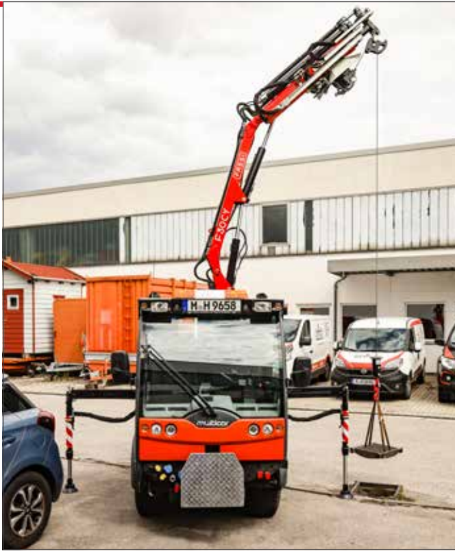
Schwere Arbeit leicht gemacht: Das FASSI/Trägerfahrzeug-Konzept beim Heben eines Gullydeckels
